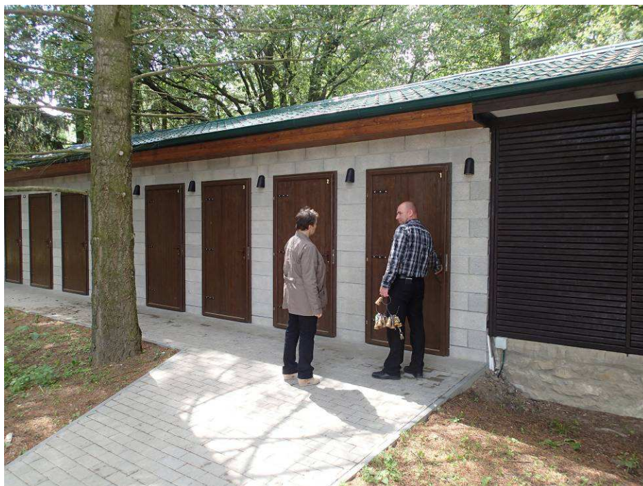
Obr. Úschovna a půjčovna kol v ATC Strážnice má i opravnu kol a je inovativní službou pro celý region
